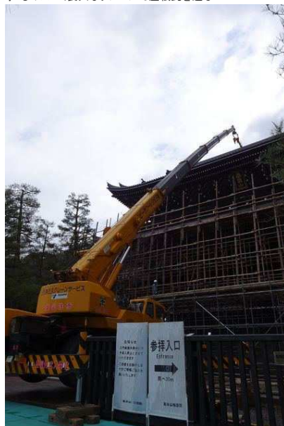
知恩院三門 瓦工事 ものすごく長大なクレーンで屋根瓦を運ぶ
